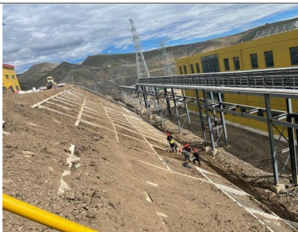
工业场地边坡覆土
