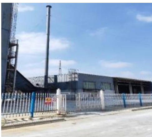
电石破碎除尘废气、加料斗置换废气排气筒
