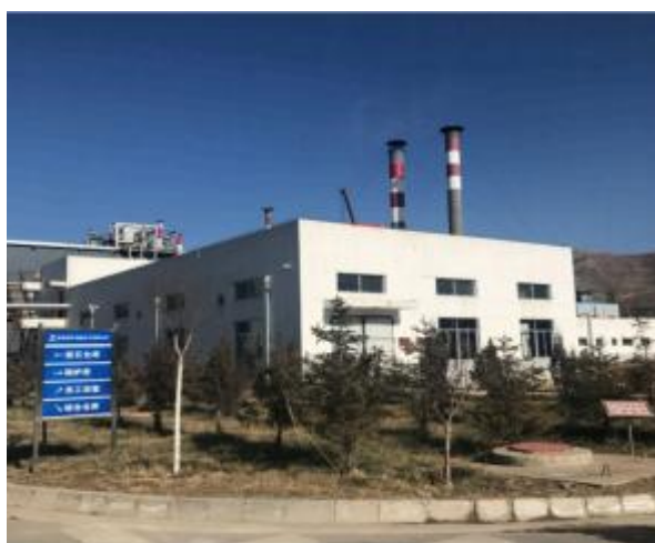
锅炉房及锅炉废气排气筒
