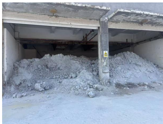
含氟石膏渣库
