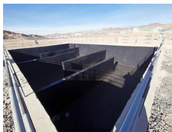
尾矿库下游的渗滤液收集池
