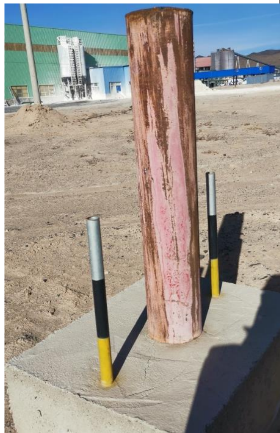
尾矿库西侧监测井（地下水侧向）
